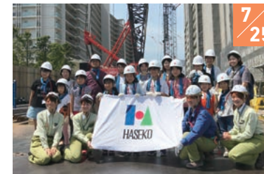
(仮称) 摂津市千里丘新町 A敷地計画建設工事(Ⅱ・Ⅲ工区) (長谷工コーポレーション)
