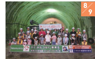
新東名高速道路 谷ヶ山トンネル西工事 (三井住友建設)
